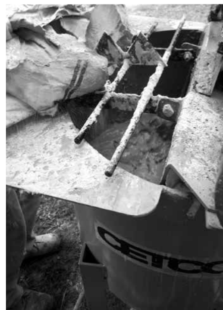
Blandning av BENTOGROUT® i CETCO-blandaren
